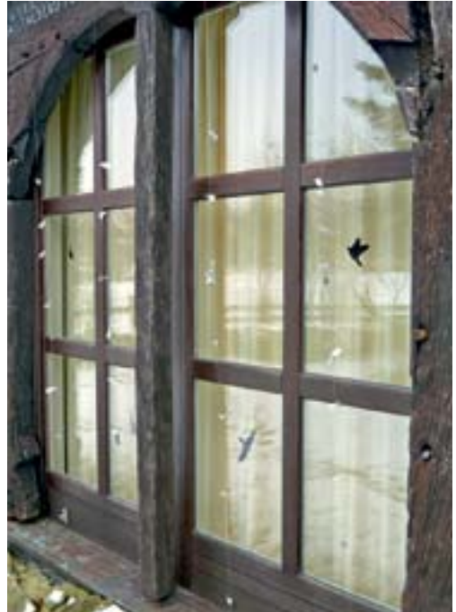
„Sichtschutz“ durch Nylonfäden und Alustreifen
